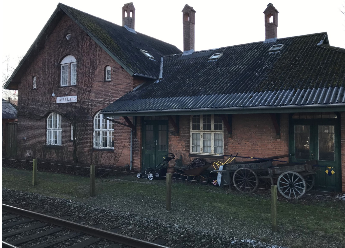
Havrebjerg Station set fra øst (desværre i skyggen). Alle vinduer og døre er fra 1897. Med et skifertag vil bygningen bliver meget smuk.
