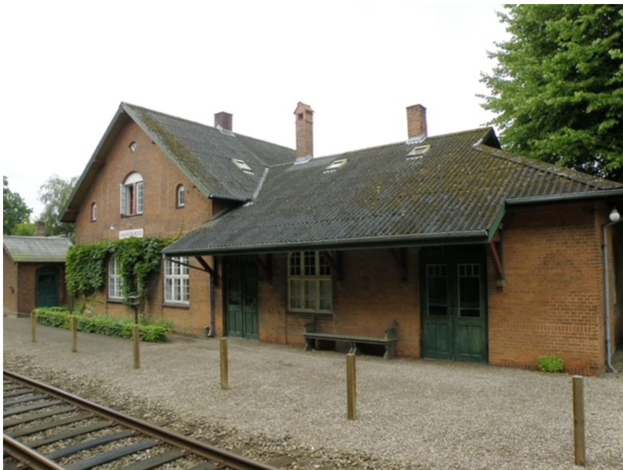
Hovedbygningen set fra nordøst
