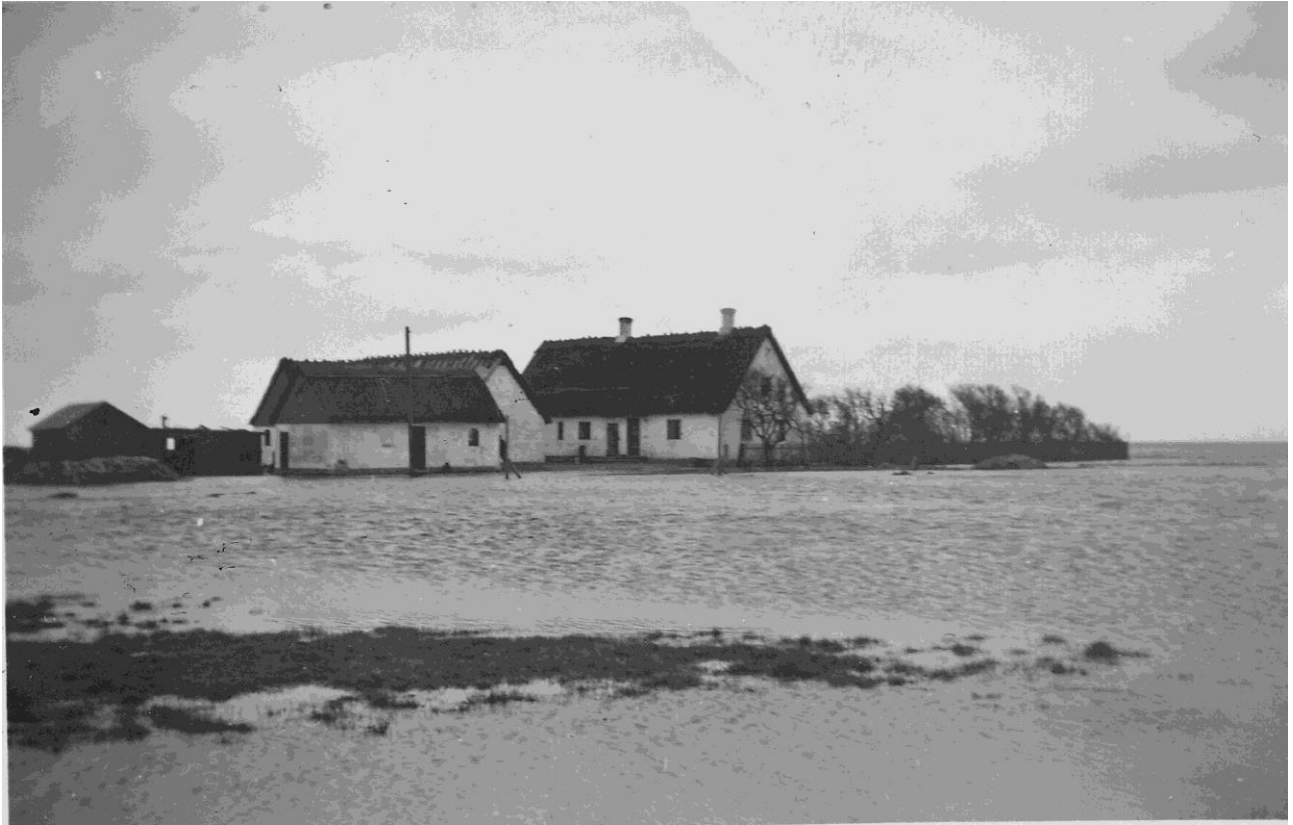
Ejendommen 1933 (Foto fra oversvømmelsen i 1933)
