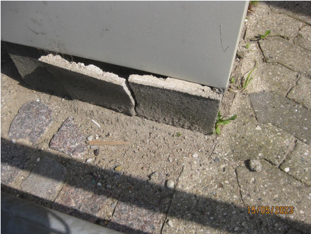
Afslag af sokkelpuds på søjler
