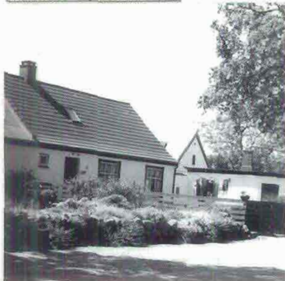
STRANDALLE 15, matr.nr. 11e.
