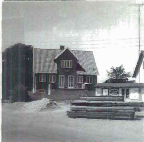
STRANDALLE 6, matr.nr. 9i.
