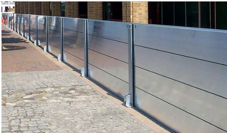
Eksempel på beskrevet mobile højvandsmur.
