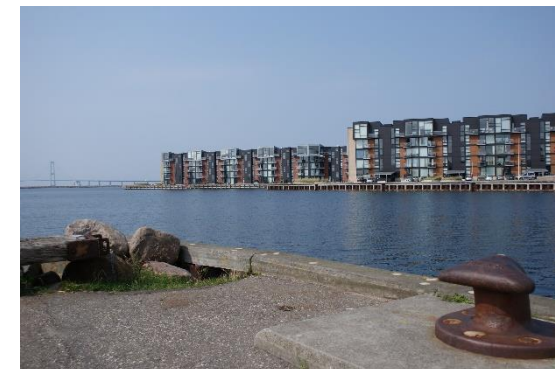
Ved Pierne i Korsør er der mulighed for at etablere flere boliger som en blanding af tæt-lav boliger og etageboliger.
