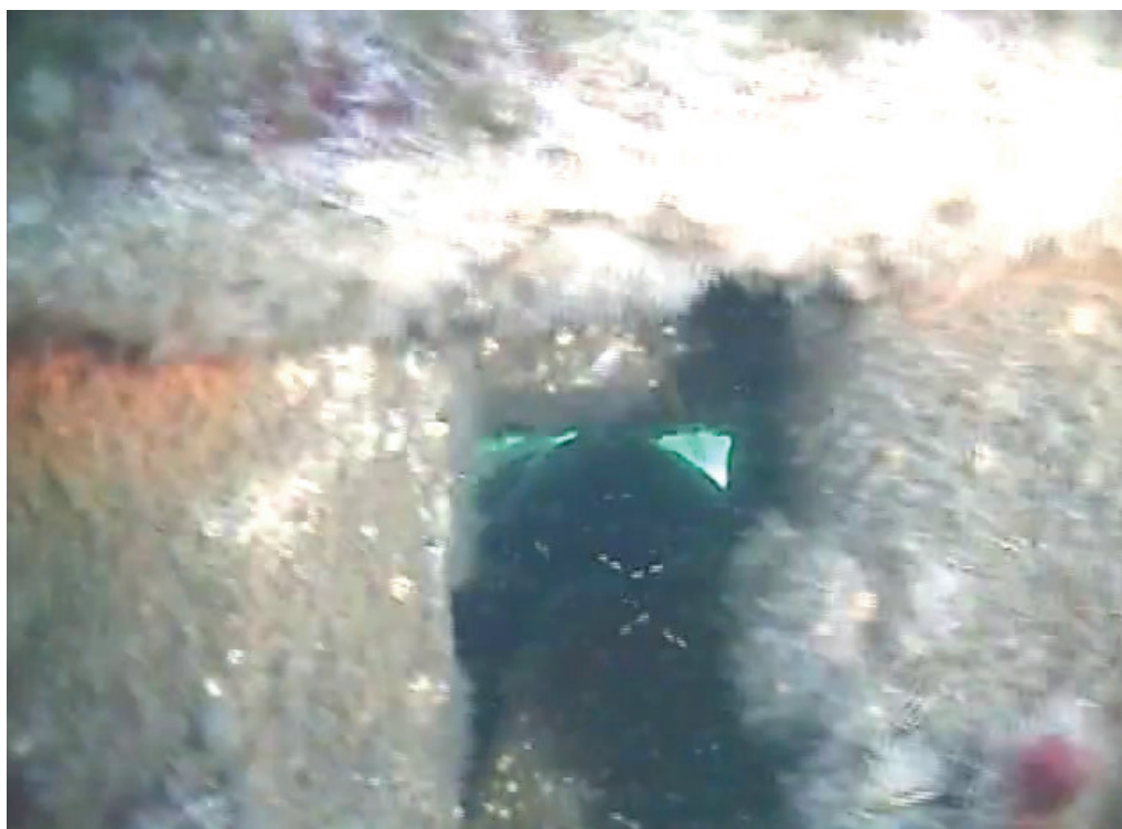
Foto 19: Sætning af stenfyld under betonoverbygning, umiddelbart bag ved molehovedet.
