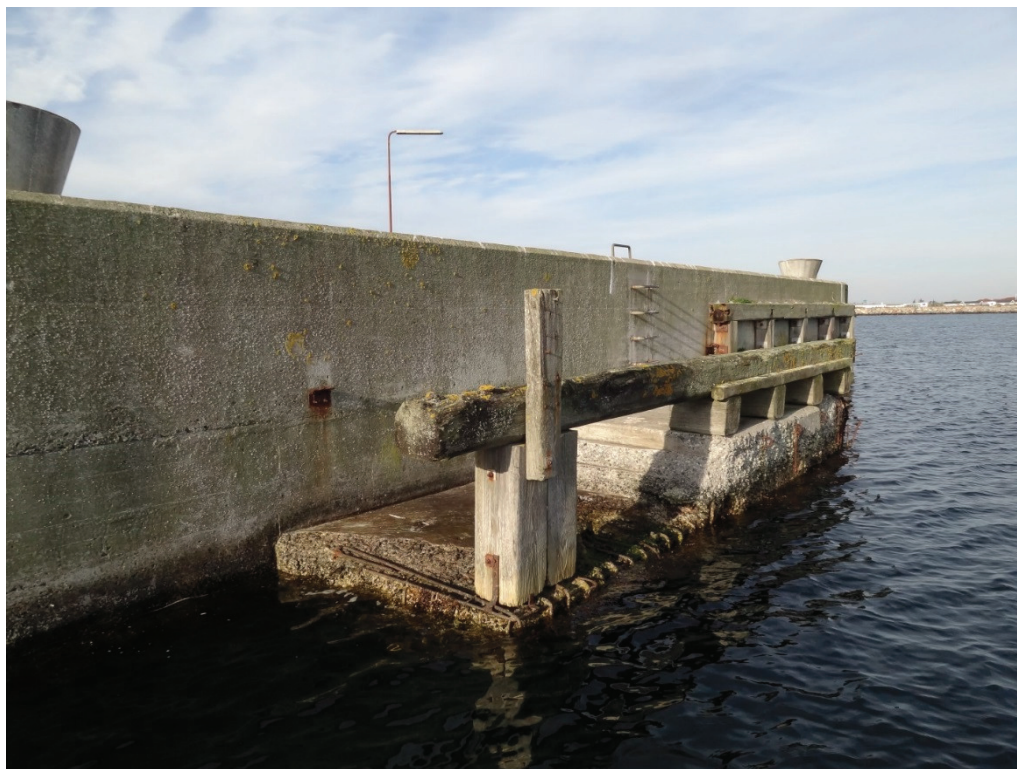
Foto 22: Eroderet platform på den østlige side af Oliepieren.
