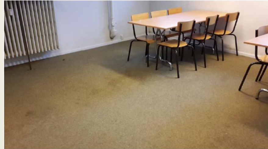
Foto 12: Nålefilt på kældergulv og indvendig efterisolering af kælderydervægge i beboerlokale
