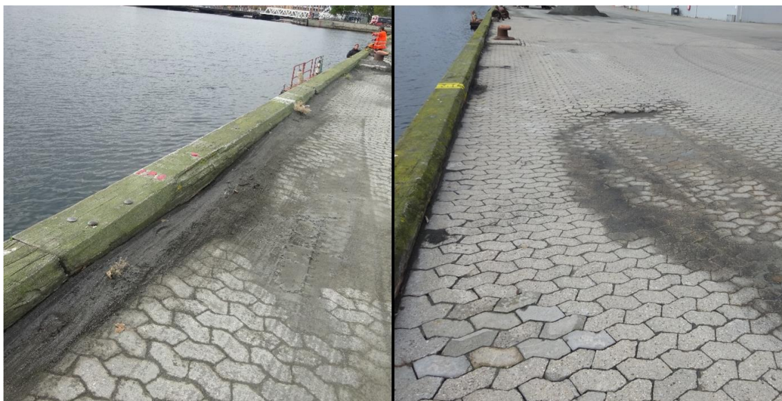
Figur 7: Sætninger mod kajkant tv. Sætninger længere ind på land th.
