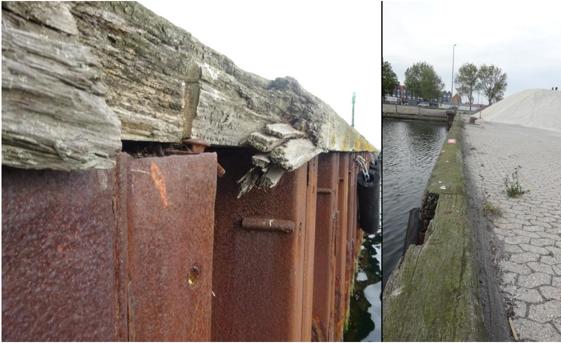
Figur 19: Flækket hammer.
