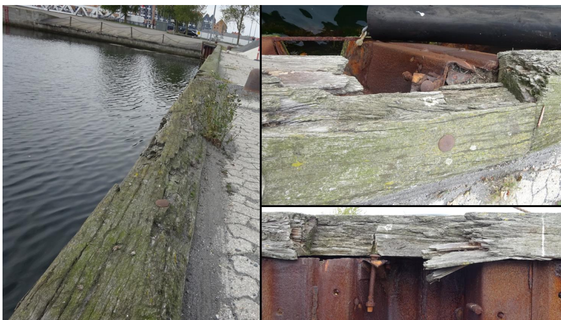
Figur 8: Illustrationer af hammer i dårlig stand.
