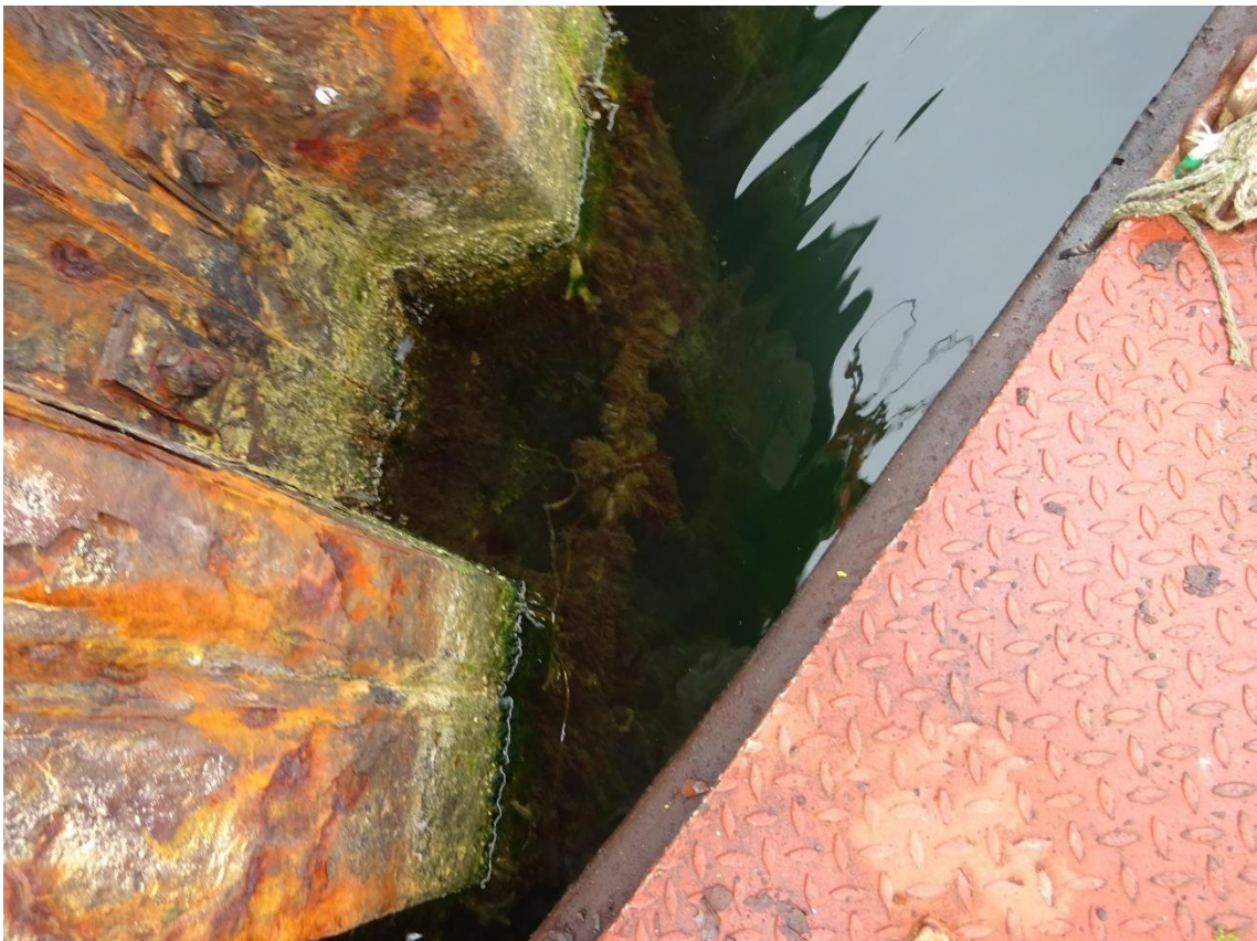
Figur 20: Vandret anode uden anode materiale tilbage.
