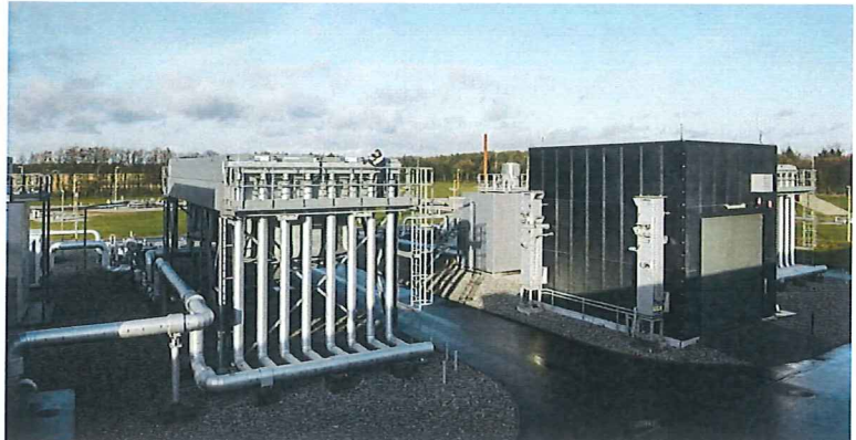
Kompressorbygning og fritstående køleenhed
