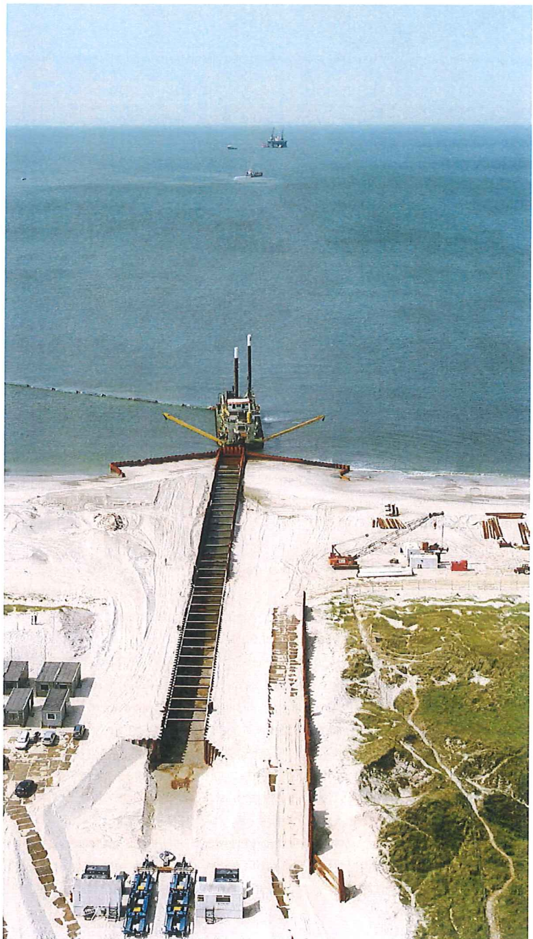
Spunset ledningsgrav, hvor gasrørledningen ilandføres ved kysten
