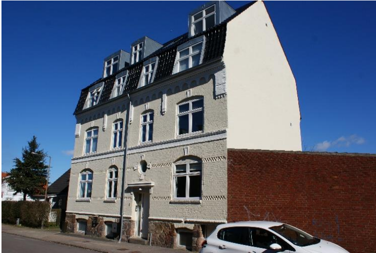
Billedet viser den eksisterende bygning på Møllevvej 3.
