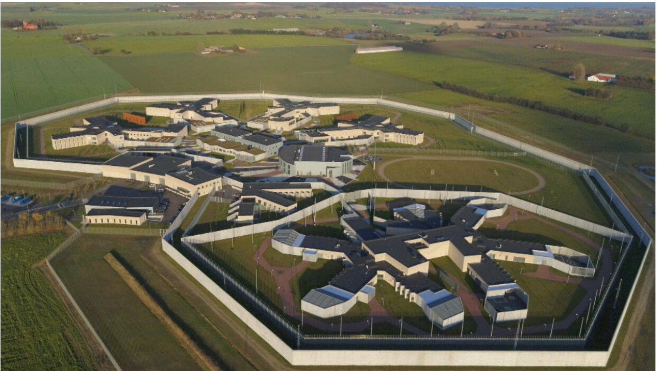
Skråfoto af Storstrømfængsel, med illustration af den rå betonmurs indvirkning på landskabet.
