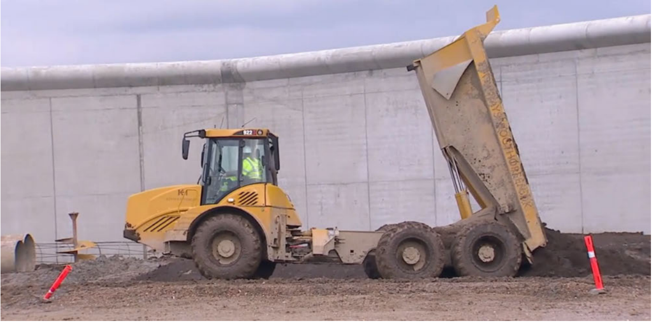
Gadeperspektiv af betonmur ved Storstrømfængsel.
