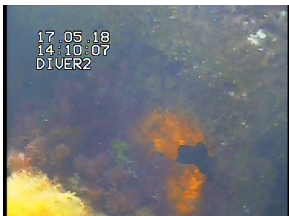
Mindre hul under udspringstårn 8 x 8 cm og mere en 2 m dyb
