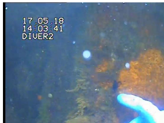
Mindre hul under klatrevæg 10 x 7 cm, dykkeren opdager det kun fordi der ingen begroning er.
