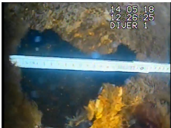
Hul 20x17 kote 0,9 m dybde ca 1,5 m
