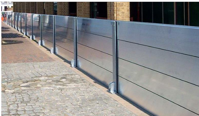
Eksempel på beskrevet mobile højvandsmur.
