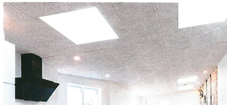
Lofter: Hvid, akustikregulerende træbeton.
