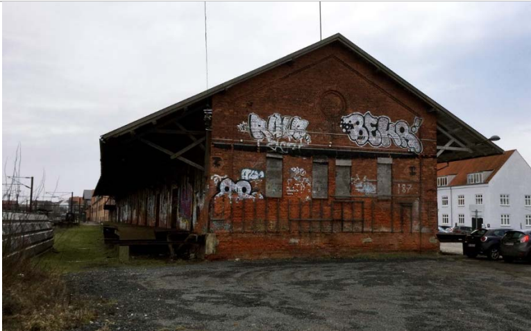
Godsbanebygningens vestgavl som den står i dag.
