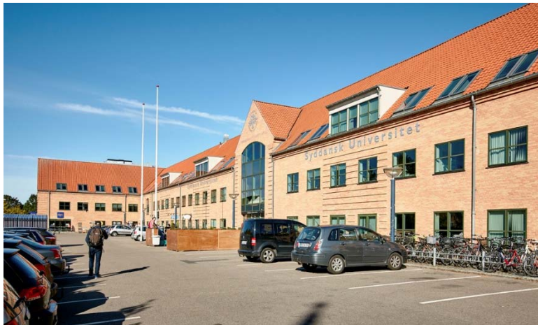
Perron 1-bygningens facade mod Sdr. Stationsvej.
