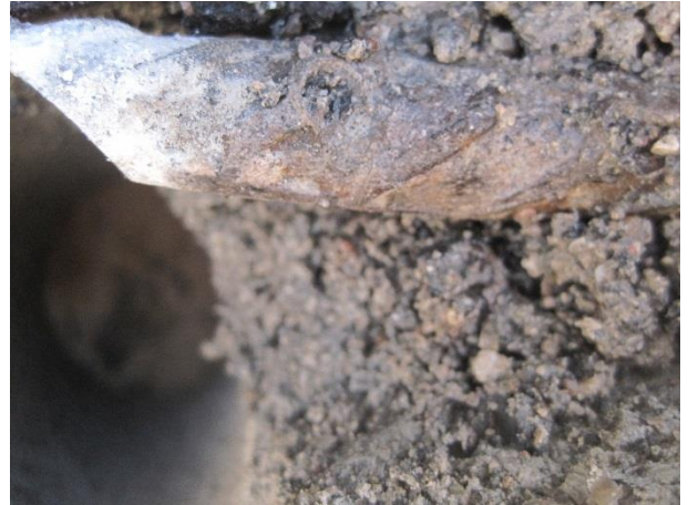
14. Behugning af overside: Uden korrosion.
