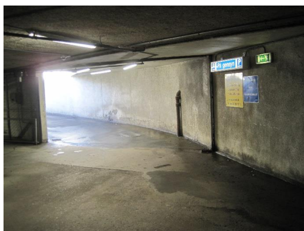
18. Kældergulv: Opkørselsrampe (NØ).
