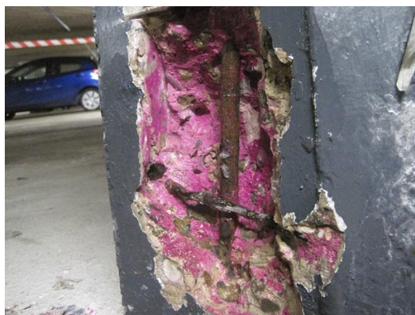
6. Behugning af søjle nr. 67: Bestemmelse af carboniseringsfronten.
