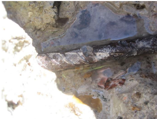
15. Behugning af overside: Uden korrosion.
