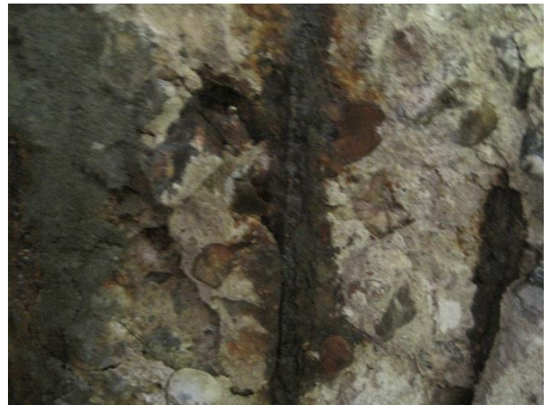
4. Underside af dæk: Gennemtæret armering.
