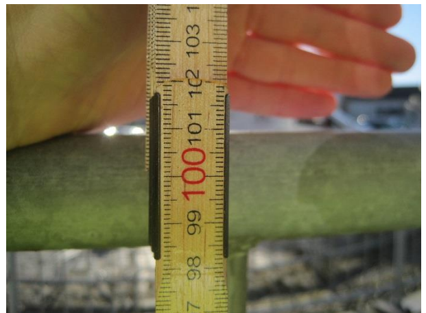
28. Trappenedgang N: Højde af rækværk.
