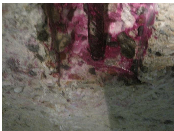
11. Behugning af loft (nr. 5): Bestemmelse af carbonatiseringsfronten.
