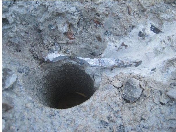
13. Behugning af overside: Uden korrosion.
