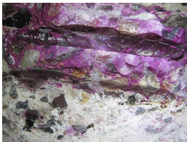
10. Behugning af loft (nr. 5): Bestemmelse af carbonatiseringsfronten.
