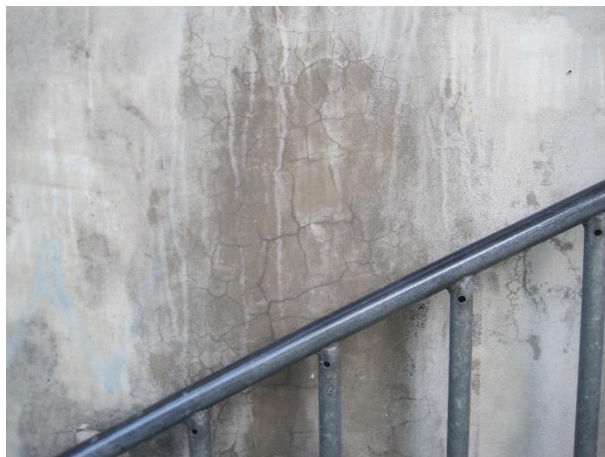
33. Trappenedgange S: Netrevner ved trappenedgang.
