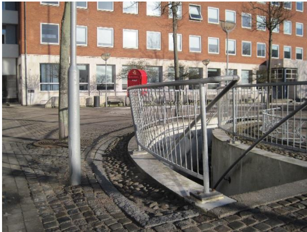
25. Trappenedgang N: Rækværk ved trappenedgang i nord. Skævt pga. påkørsel.
