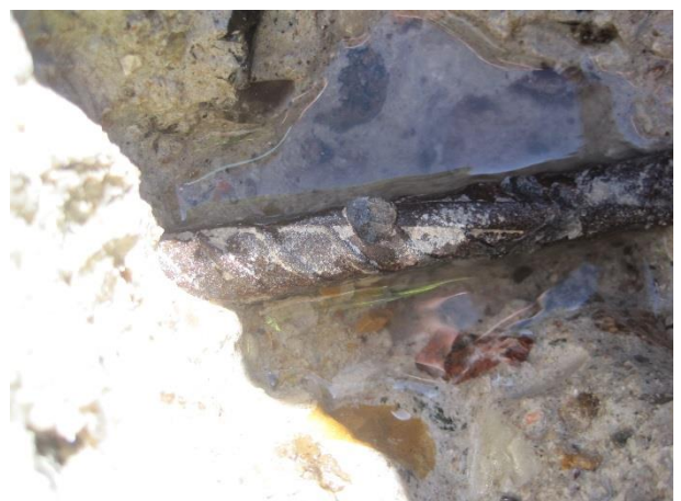
42. Belægning over dæk: Behugning af overside dæk til spiralarmering (NØ).
