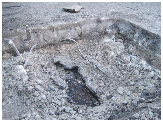
40. Belægning over dæk: Opbrydning af asfalt, beskyttelsebeton og fugtisolerings. Porøs beskyttelsesbeton (NØ).
