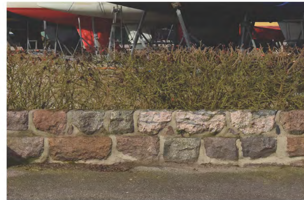
STENBELAGT FORHØJET MUR
