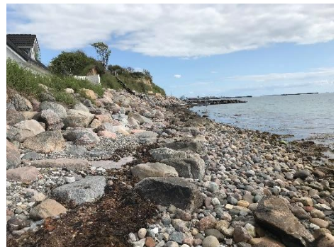
4. Skråningsbeskyttelse fortsætter langs klinten.
