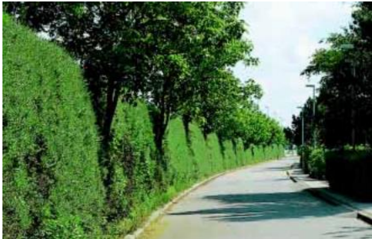
Her ses et eksempel på en begrønnet støjskærm. Kilde: Vejdirektoratet – Støjskærme, Eksempler og erfaringer – Rapport nr. 183, August 1999
