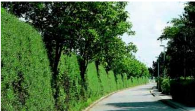
Eksempel på begrønning af støjskærm til venstre på billedet. Kilde: Vejdirektoratet – Støjskærme, Eksempler og erfaringer – Rapport nr. 183, August 1999
