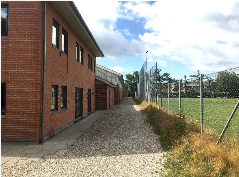
Vest om Stillingehallen planlægges institutionen tilkøbet eksisterende stinet. Stien planlægges befæstet med asfalt eller belægningssten. Stien fungerer samtidig som brandvej til skolen.
