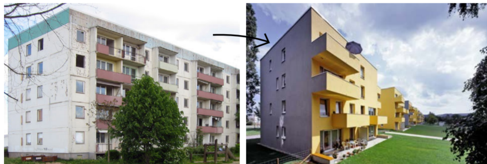
Den tyske by Leinefelde havde et stort beboelsesområde af helt enslydende boligblokke. Over en årrække blev blokkene transformeret til vidt forskellige bygningstyper - punkthuse, byvillaer, rækkehuse og lavere blokke. Elementer blev skåret ud, andre steder nye påsat, og alt i alt blev det ensartede boligblokområde til et arkitektonisk mangfoldigt kvarter.
