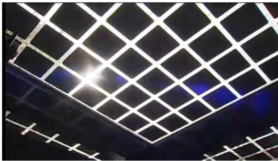
Ad. 8.2 og 8.4. Eksempel på solceller lagt som næsten vandret tagflade på diskret overdækket terrasse. Kilde: Det Grønne Hus i Køge.
