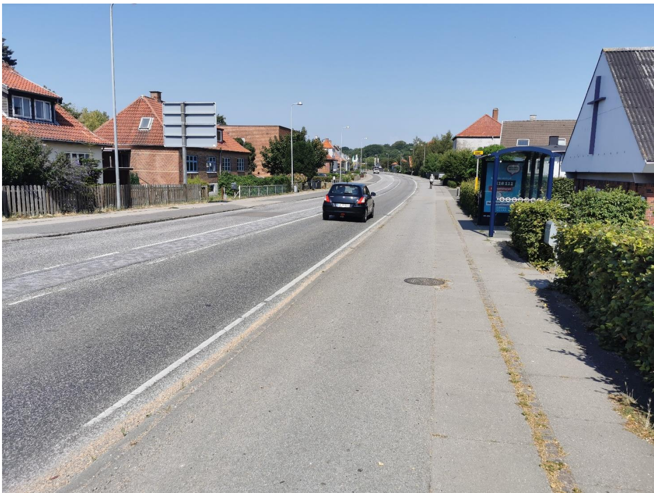
Figur 7: De fremrykkede busholdepladser frister biler til at overhale når bussen holder stille på kørebanen.
