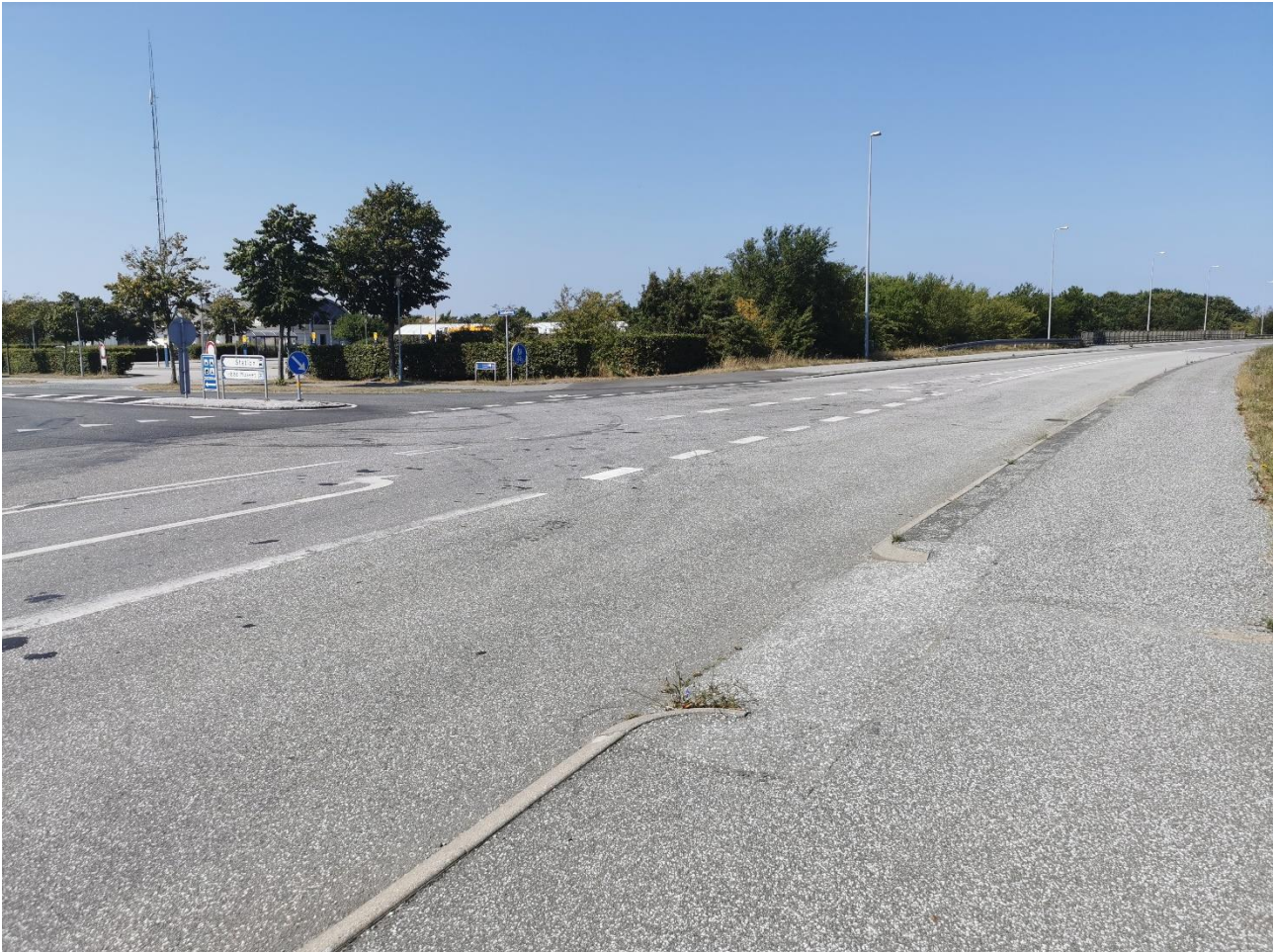
Figur 13: Ved Tårnborgvejs krydsning med Storebæltsvej mangler der krydsningsfaciliteter for cyklister.
