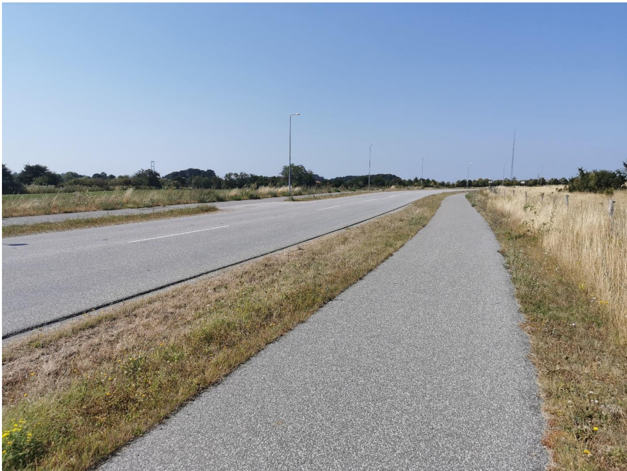
Figur 10: Der mangler belysning for cyklister på østsiden af Tårnborgevej.
