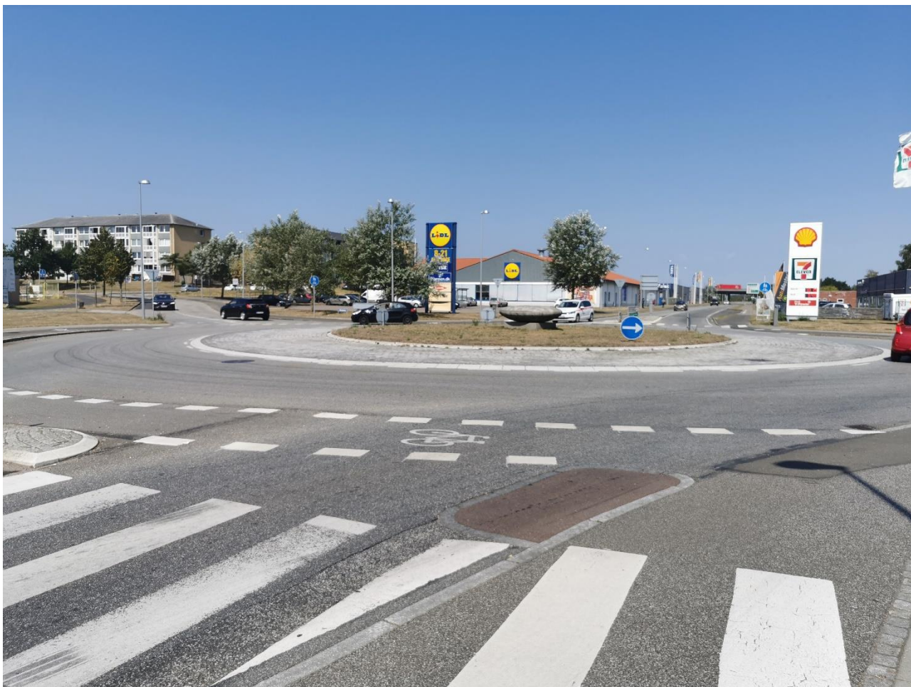
Figur 8: Alle rundkørsler på strækningen er etableret med lav midterø, hvilket øger uheldsrisikoen.
