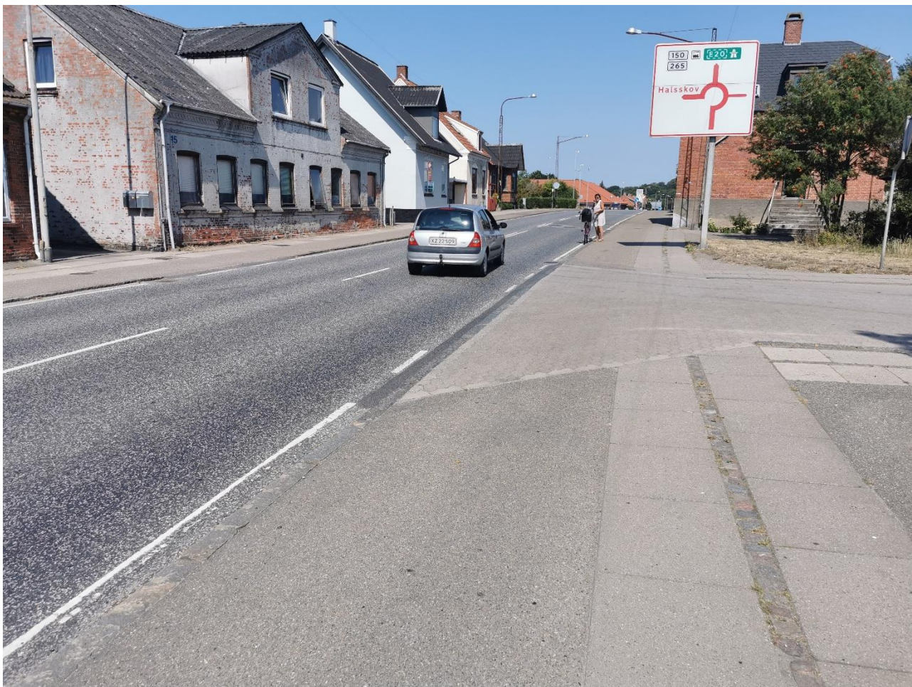
Figur 6: Cykelstier bør føres helt igennem med asfalt og der bør være højere op- og nedkørsel for biler for at reducere hastigheden i krydsningerne ved sidevejene.
