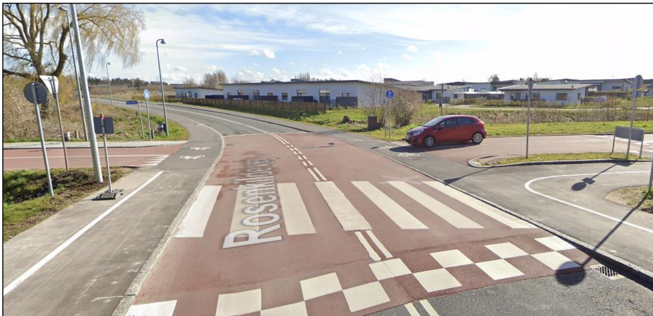
Figur 10-5 Vejkrydset Valmuevej/Rosenkildevej set mod øst
