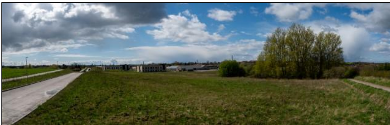
Figur 9-8 Projektområdet set fra nord med plejeboligerne i baggrunden. Til venstre ses den stamvej, der allerede er anlagt til at forsyne de næste etaper. Den passer med sit syd-sydvest-til nord-nordøstgående forløb ind i det eksisterende vej mønster.
