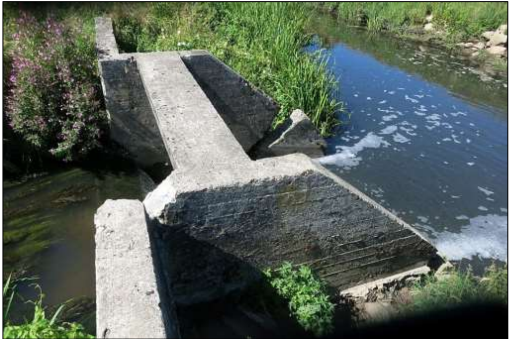
Figur 2-5 Betonbygværket, der udgør spærringen.
