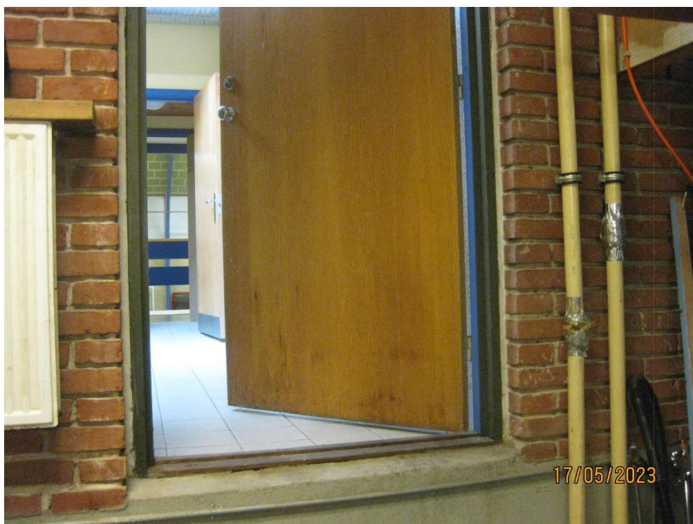
"Flugtvejsdør" i omklædning 6 til redskabsrum har et trin ned på ca. 1m. Dette skal der findes en løsning på snarest, da det kan udgøre en personrisiko.
