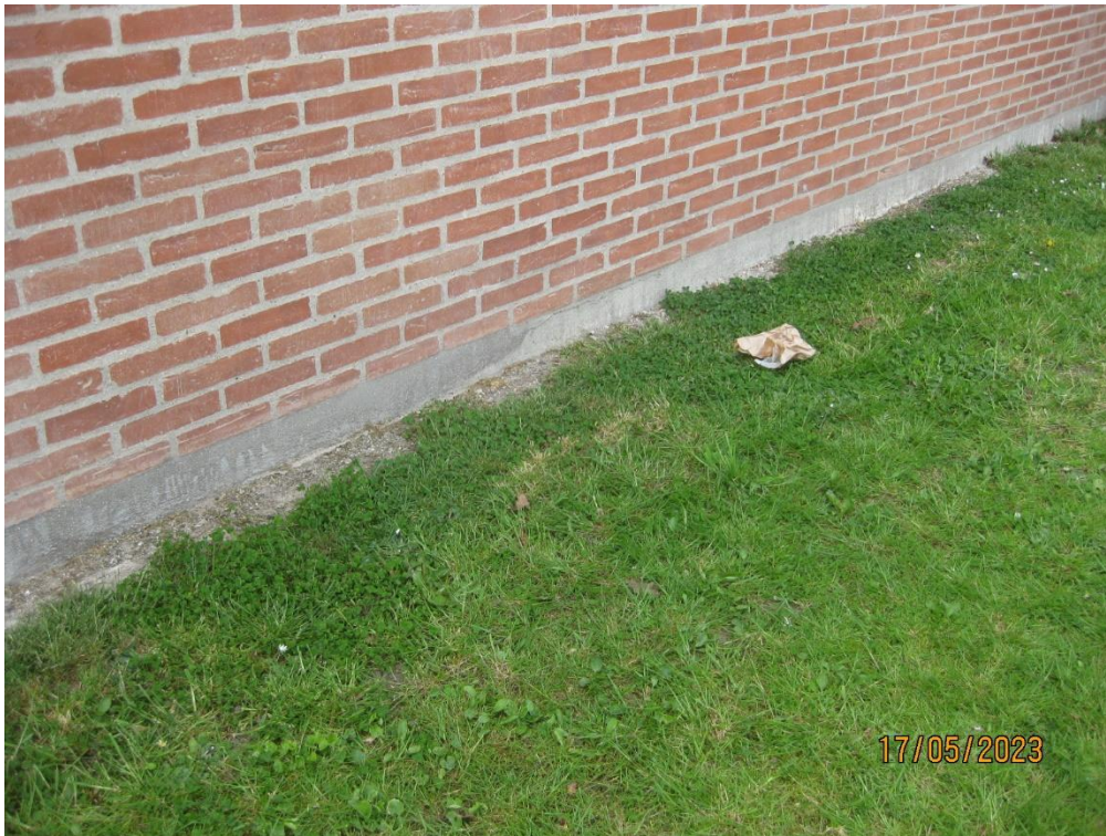
Murværk er blevet opfuget efter murbier. Sökkelpuds falder af flere steder langs nordside.
