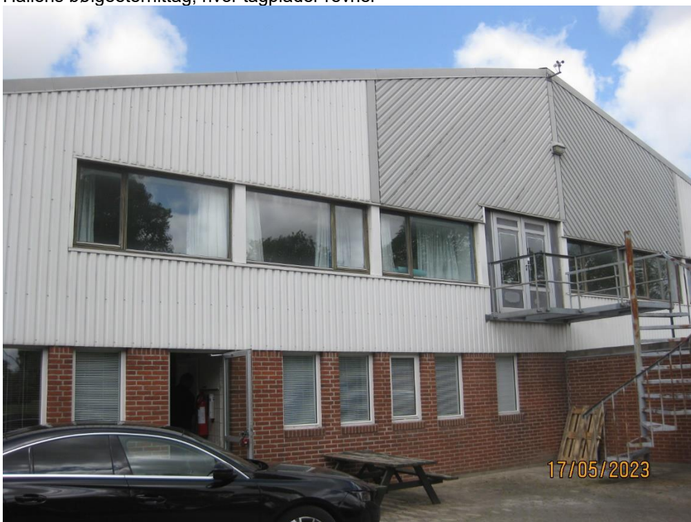
Ældre vinduer på 1.sal (Multirum mm.)
